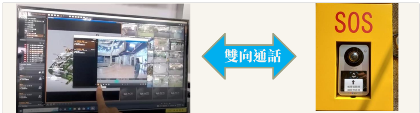
圖93 有緊急事件發生時，求救人按下緊急求救對講，訊號可透過網路傳回管理中心並跳出電子地圖。照片來源：中央大學總務處
