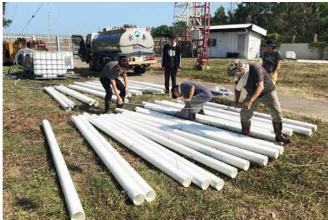
▲ 中央大學臨海觀測站一百公尺試驗井鑽探、設井及地電阻與溫度光纖監測設備安裝
